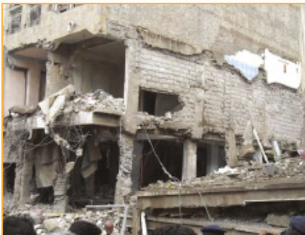
Figura 26. Edificio tras producirse una explosión.
